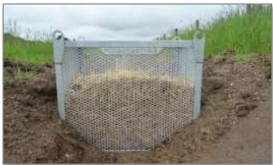
Figure 49a et 49b : filtres à paille pouvant être utilisé en phase de chantier
